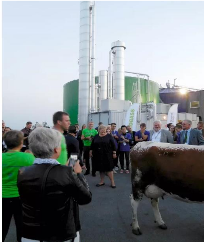
Den Magiske fabrikken i Tønsberg, Norge med Malmberg biogas oppgradering.
